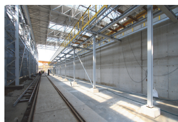
Hala Namiarowni ZGH Bolesław S.A.
