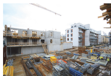
II etap osiedla Nowa Papiernia we Wrocławiu
