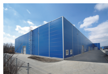
Budowa hali magazynowej dla Asetino
