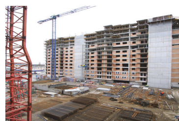
Budynek mieszkalno-usługowy budowany w ramach projektu „Parki Warszawy”
