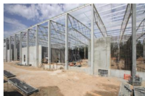
HALA MAGAZYNOWA PALIW ALTERNATYWNYCH LAFARGE CEMENT
