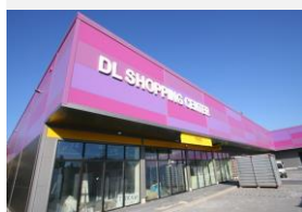
BUDYNEK GALERII HANDLOWEJ DL SHOPPING CENTER
