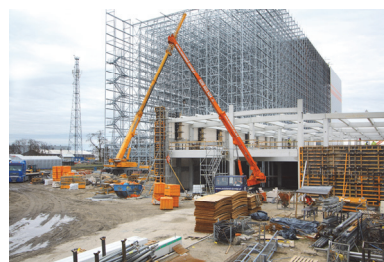
Budowa magazynu dla Amica S.A.
