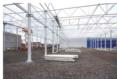
Budowa hali dla Konsorcjum Stali S.A.
