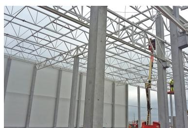
Budowa hali dla ILS Sp. z o.o.
