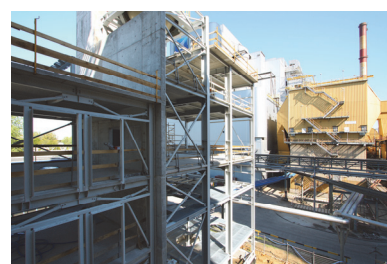
Budowa instalacji separacji popiołów dla EC Siekierki
