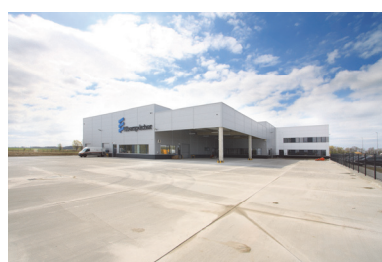
Siedziba firmy Schindler Polska
